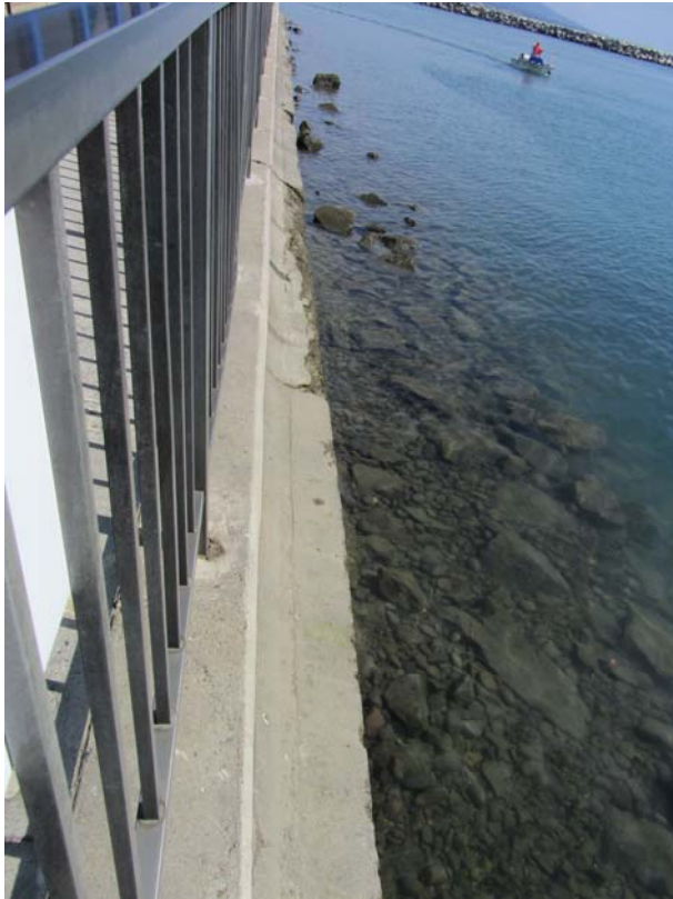
a. Type 1 Seawall
